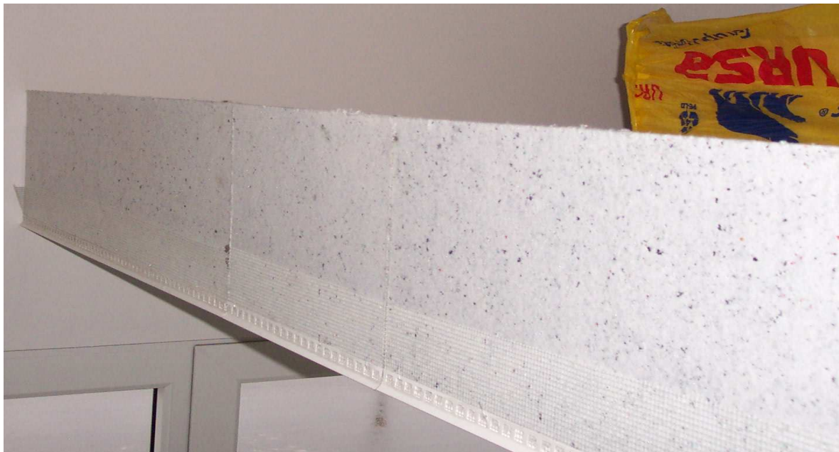
Ansicht einer bereits verklebten Stirnseite mit dem FRIWA ® - Schalungselement
